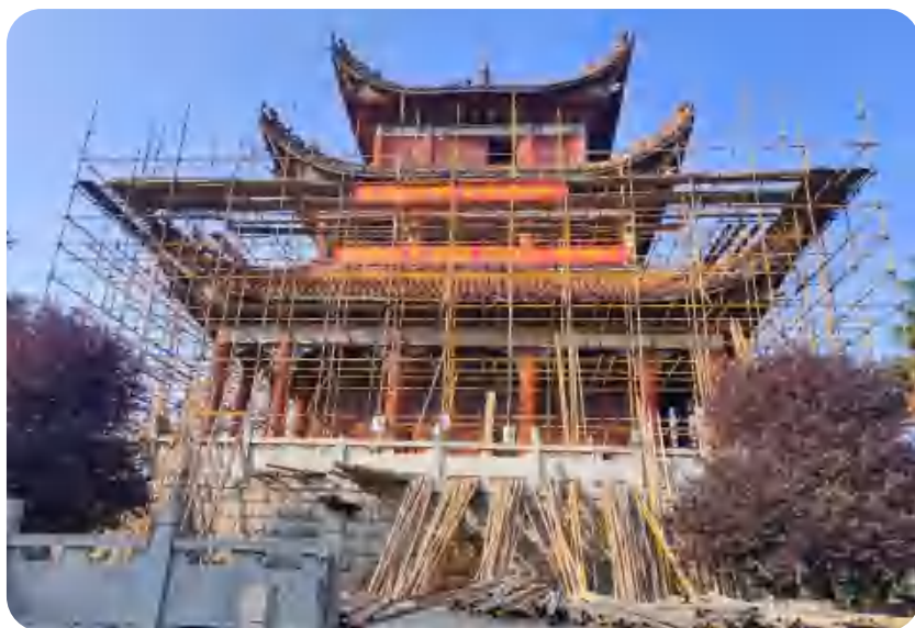
11月，远浦楼维修工程（洞庭控股摄）
