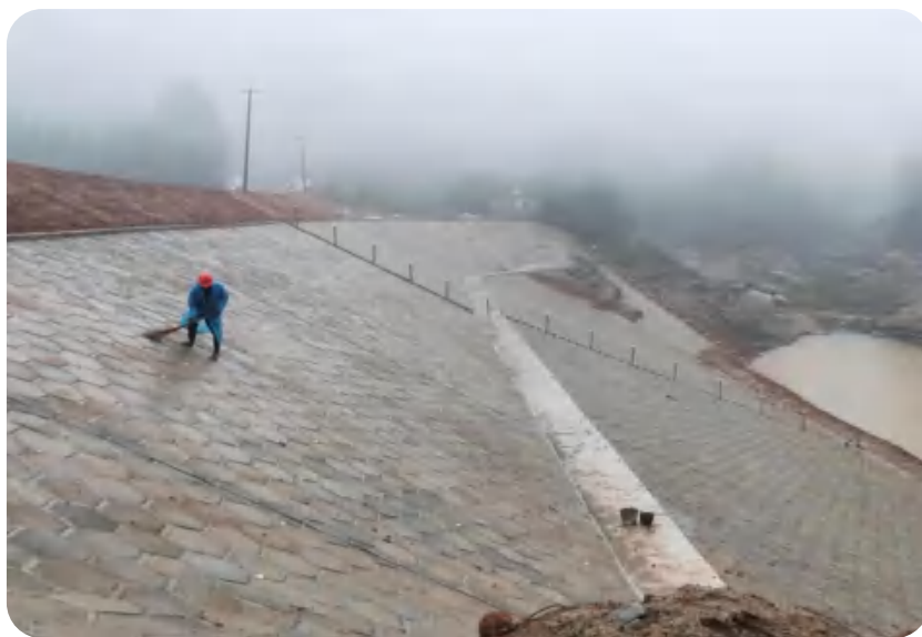
狮岭水库除险加固工程（县水利局摄）
