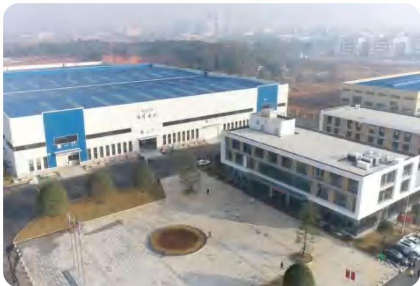
12月15日，洋沙湖公司承建的昊志机电厂房建成投产（洋沙湖公司摄）
