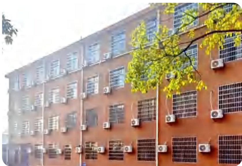
2021年秋季学期，全县中小学和幼儿园教室、学生宿舍和教师办公室空调全部安装到位（县教育局摄）
