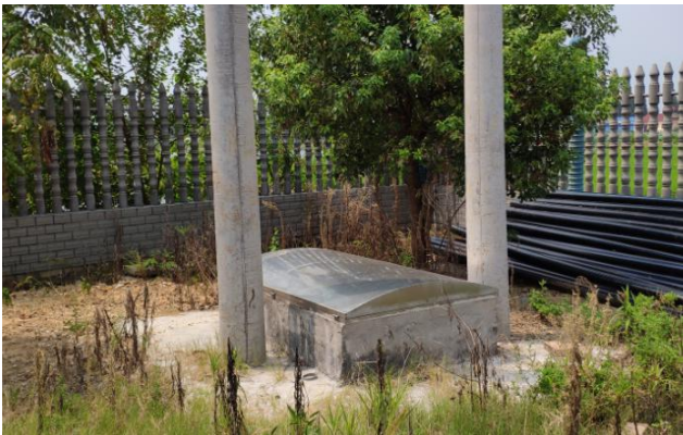
图 4-7 水厂已建围栏照片
