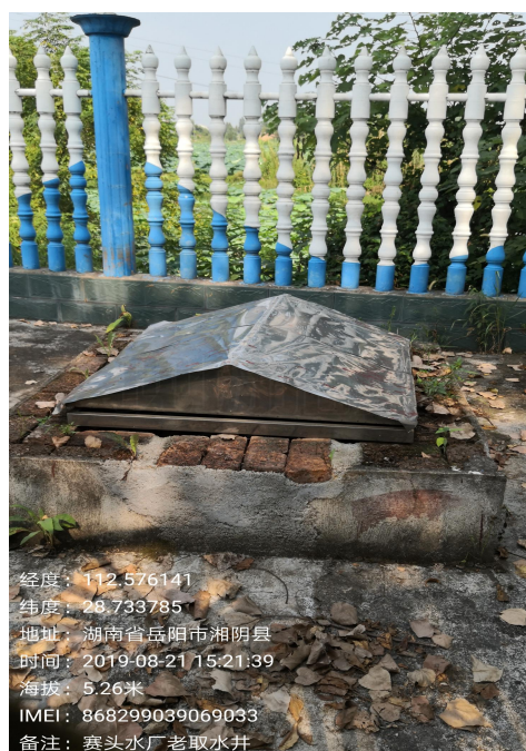
赛头水厂老水井照片
