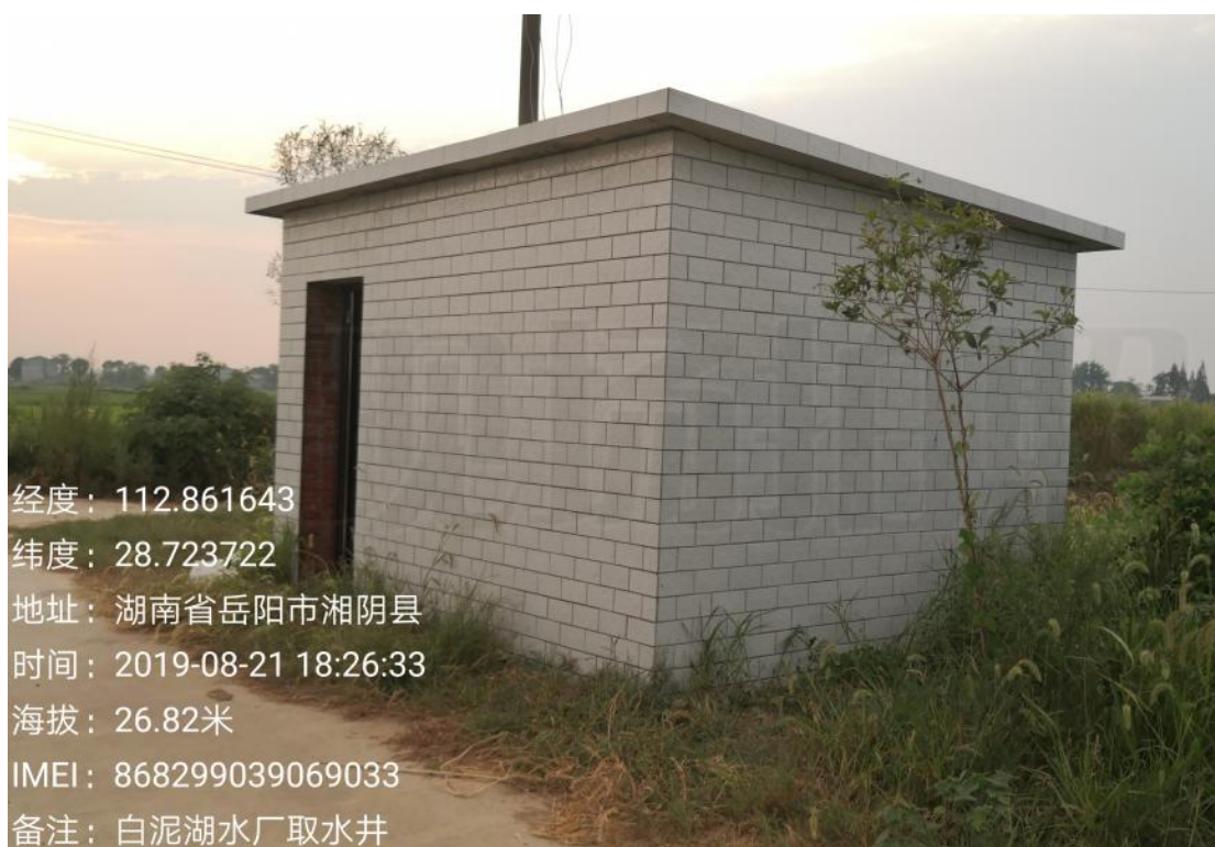
白泥湖水厂的已建水井房
