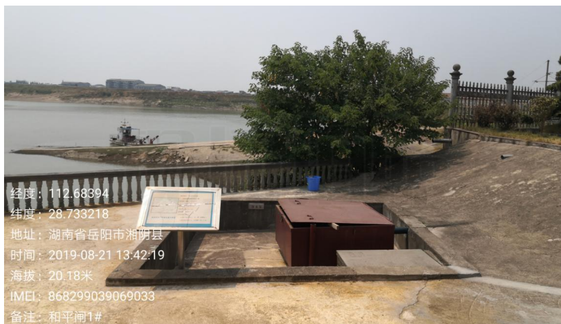
1#水井现场照片
