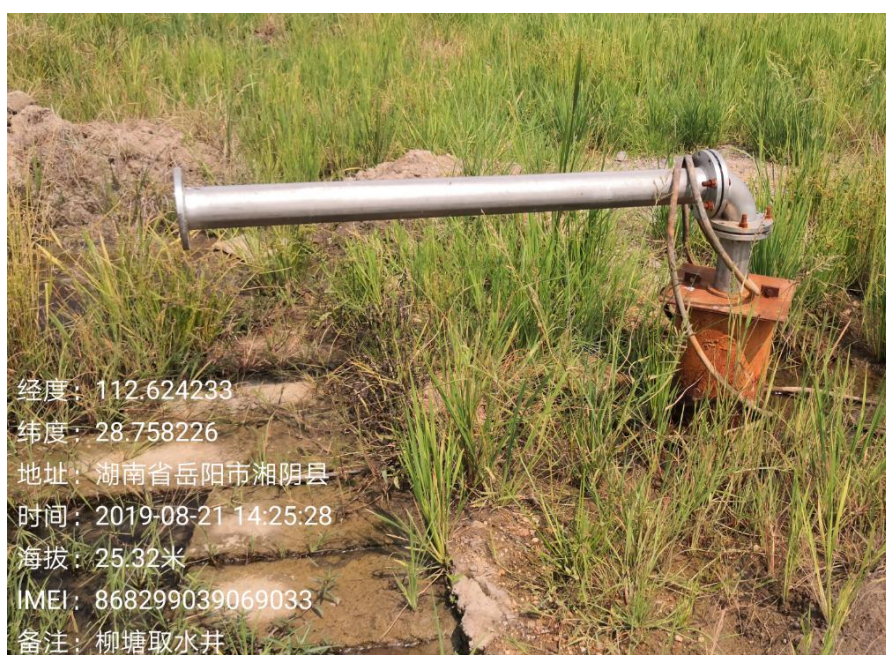
已建成的新水井照片
