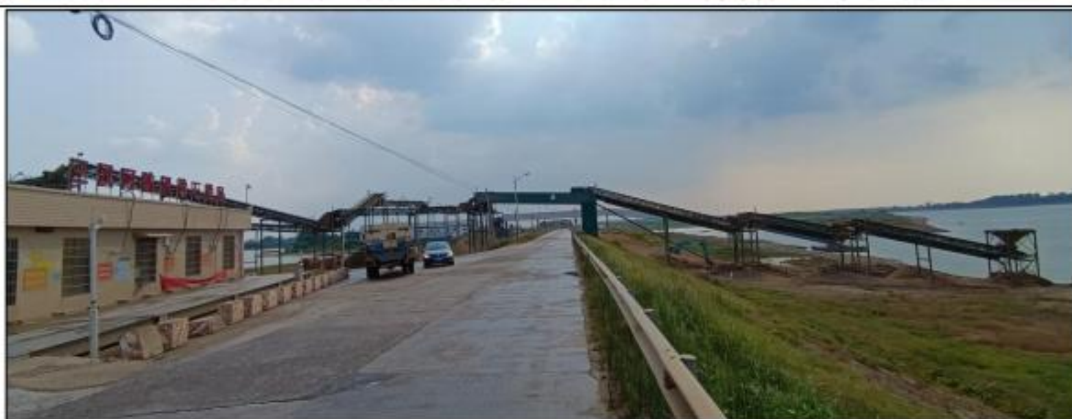
图 2.2-1 三汊河集散中心现状照片
