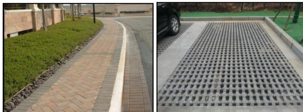
图 2-11 透水铺装示意图
