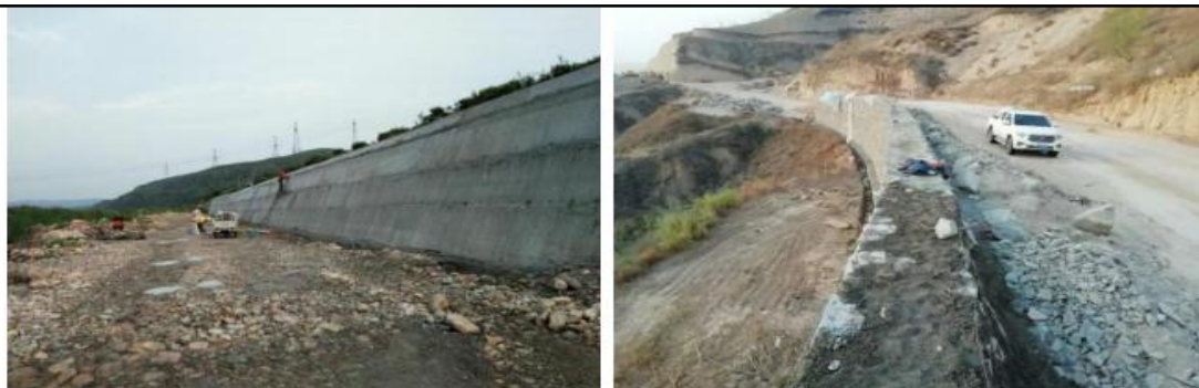
图 2-10 现浇混凝土挡墙、浆砌片石挡墙
